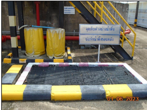
ภาพที่ 2-7 ปอดักไขมันและบ่อกักน้ำทิ้งภายในพื้นที่คลังฯ
